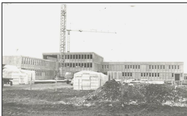
Construction de l'externat (Régional de Cosne, 23 avril 1976) (4)
